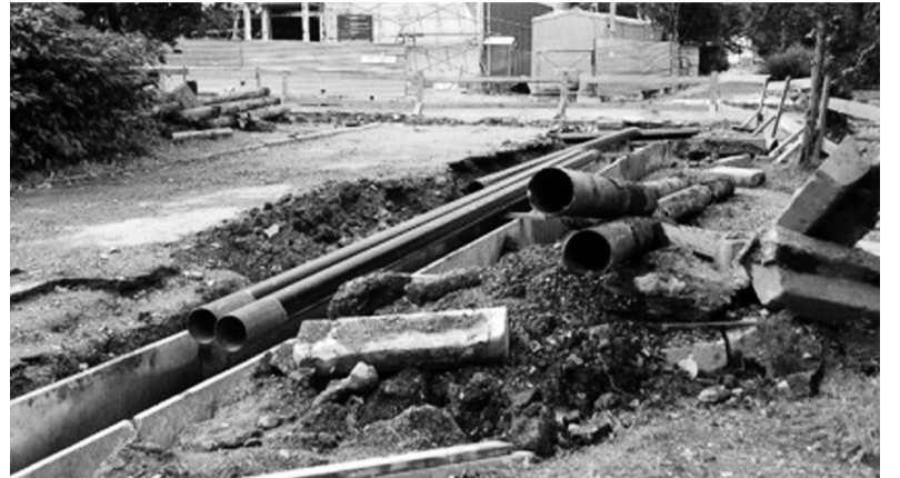
Ремонтировать теплотрассы начали еще в июне.
